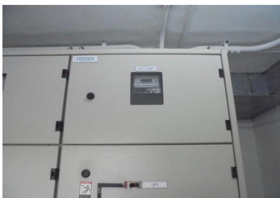
รูปที่ 11 ตู้ควบคุมระบบมิเตอร์ไฟฟ้า
