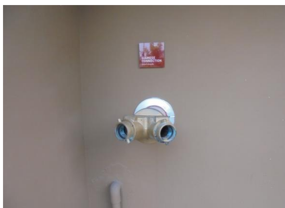
รูปที่ 27 หัวรับน้ำดับเพลิงชนิดข้อต่อสวมเร็ว
