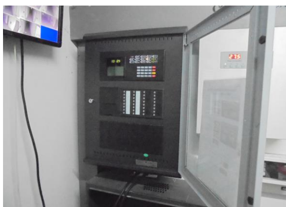
รูปที่ 23 ตู้ควบคุมระบบเตือนภัย
