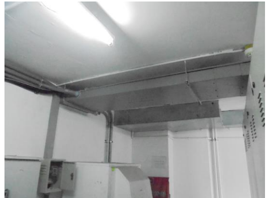
รูปที่ 20 ติดตั้งอุปกรณ์เดินสายไฟฟ้า
